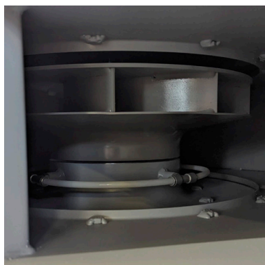
Ventilatore ad alta efficienza, predisposto per misurare le differenze di pressione in aspirazione High efficiency fan, prepared to measure inlet pressure differences
